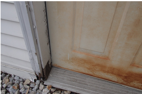
DOOR CORROSION
